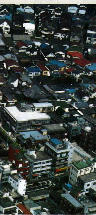
母校空撮 (手前が折戸通り)
